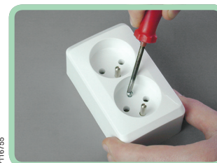
P116755 Helyezze vissza a burkolatot és rögzítse a csavarral.
